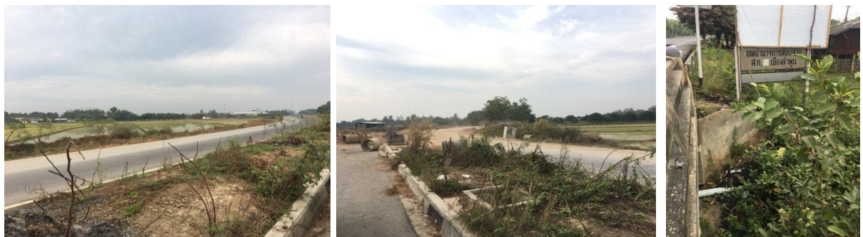
ภาพที่ ๔-๖ บริเวณที่จะทำการก่อสร้างระบบประปา แต่ยังไม่ได้ดำเนินการ เนื่องการติดปัญหาเรื่องการขออนุญาตใช้พื้นที่
